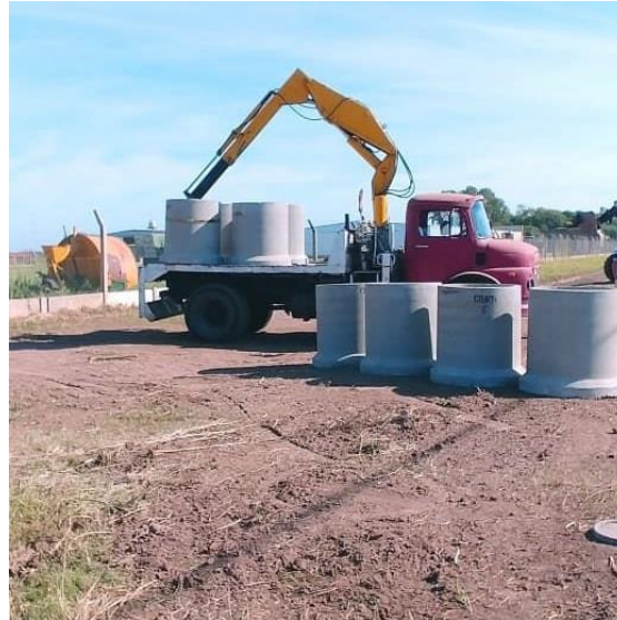
Figura 11. Obras de entubamiento pluvial en Barrio Falucho. Fuente propia del municipio
