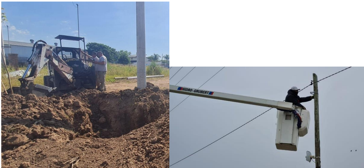
Figura 13. Instalación de luminarias en Barrio Falucho. Fuente propia del municipio
