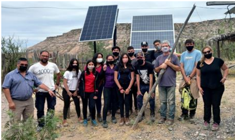
Figura 10. Instalación de un sistema solar fotovoltaico de 1 Kw de potencia, en puesto rural, en el marco de prácticas profesionalizantes y voluntariado RAMCC
