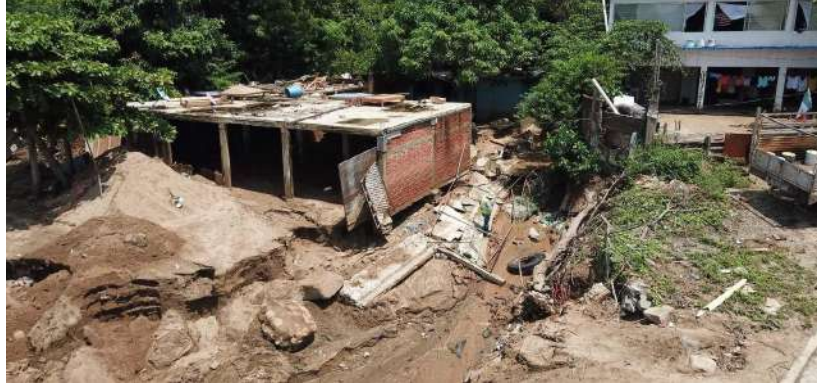
Fotografía 6. Deslizamiento en El Colomo en tormenta tropical Hernán 2020.
