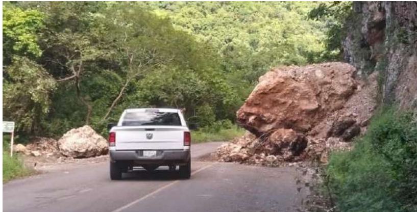
Fotografía 7. Derrumbe en carretera Manzanillo-Minatitlán.
