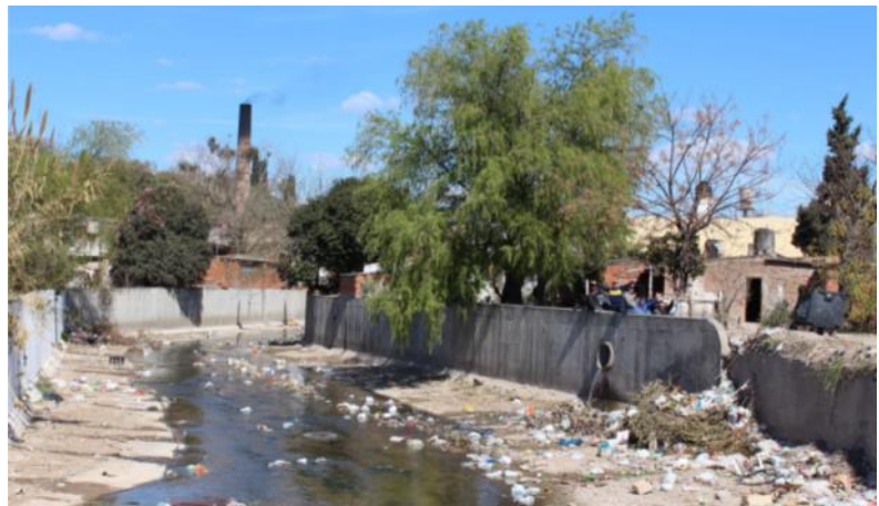
Figura 23. Estructura de paso sobre el cauce del Arroyo Antoñico (arriba) y asentamientos junto al cauce del Arroyo Antoñico en situación de riesgo (abajo).
